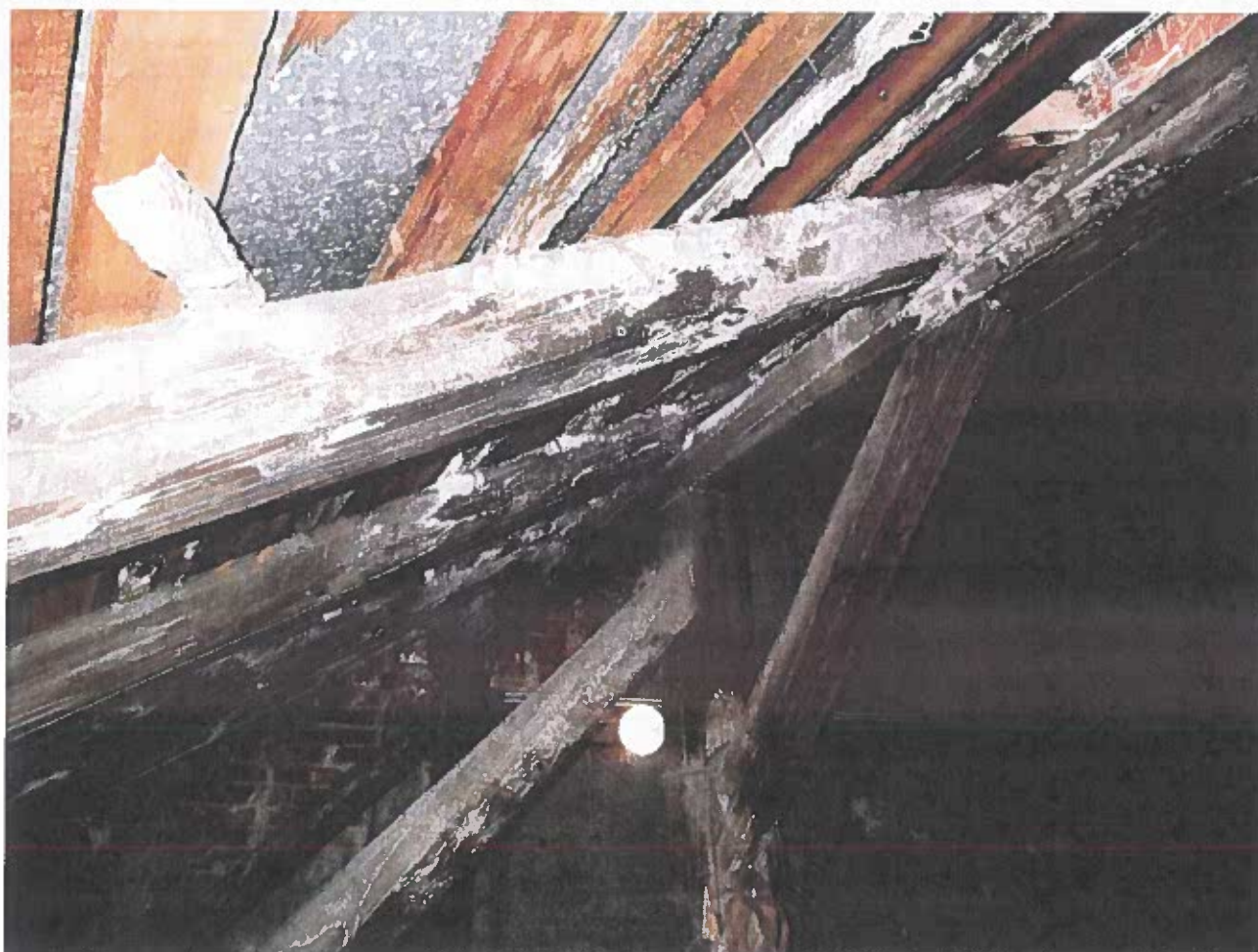
Silne zaplesneté krokvy aj trámy krovu.
