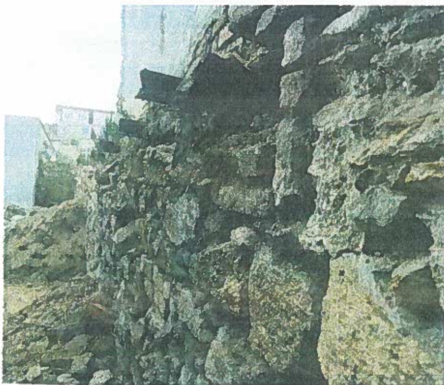
Degradácia pojava a rozsiahle výlomy hradobného múru.
